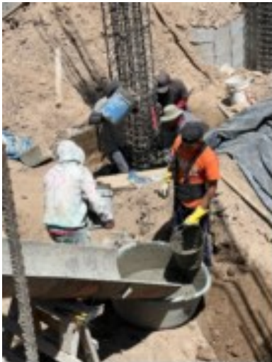
Foto: Personal de una constructora realizando fundición;
